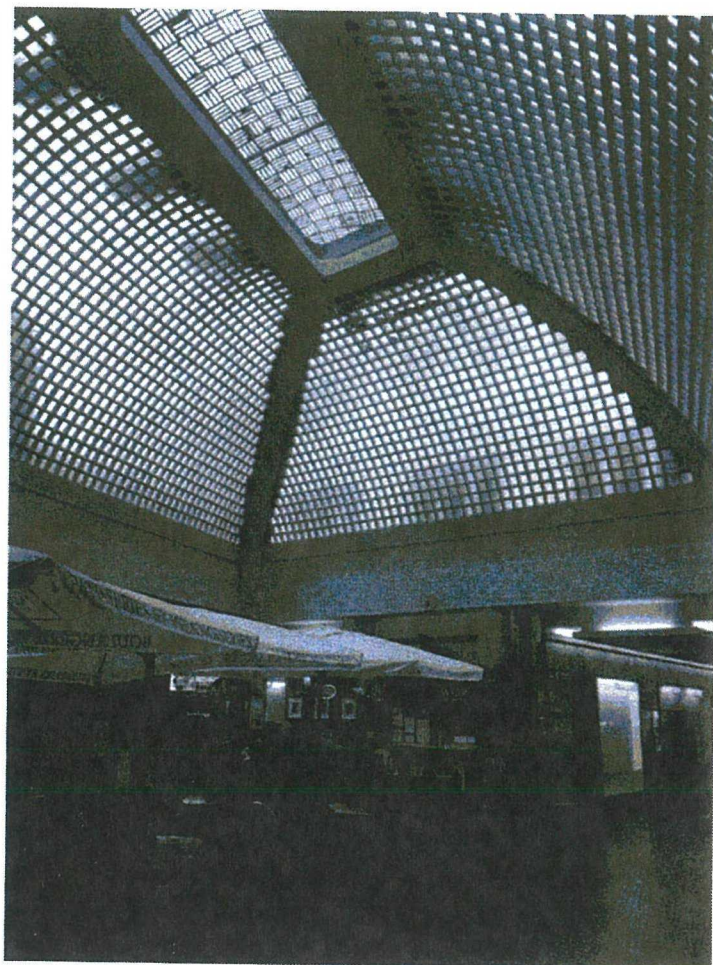
Zastřešení pasáže sklobetonovou skořepinou
