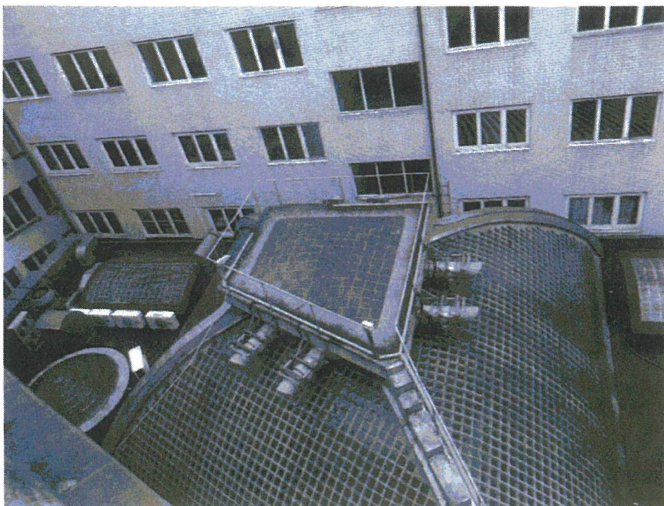
Vnitroblok s pohledem na sklobetonovou skořepinu zastřešení obchodní pasáže
